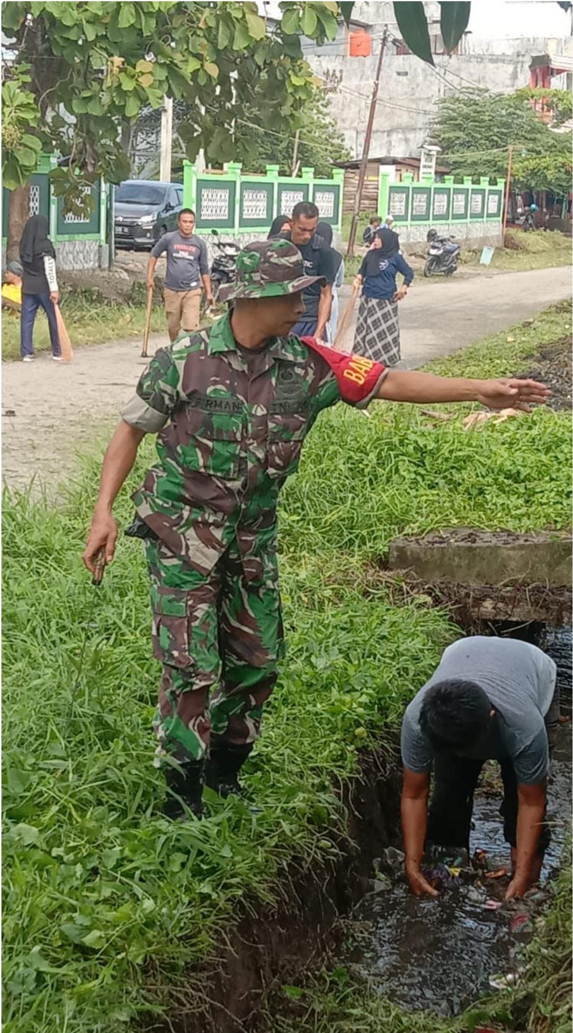
Kegiatan ini dilakukan untuk membersihkan parit dari material sampah dan rerumputan yang menyumbat aliran air. Material sampah yang menumpuk di saluran drainase dapat menyebabkan tersumbatnya aliran air, berpotensi menciptakan genangan air, dan menjadi sarang penyakit. Oleh karena itu, pembersihan secara rutin sangat penting untuk mencegah dampak negatif tersebut.
